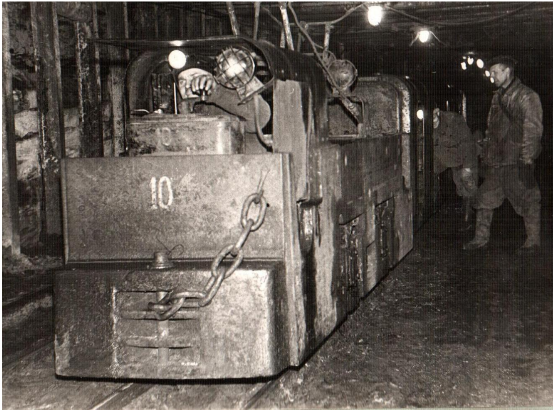
К месту работы и обратно подземные рабочие доставлялись специальными пассажирскими поездами
