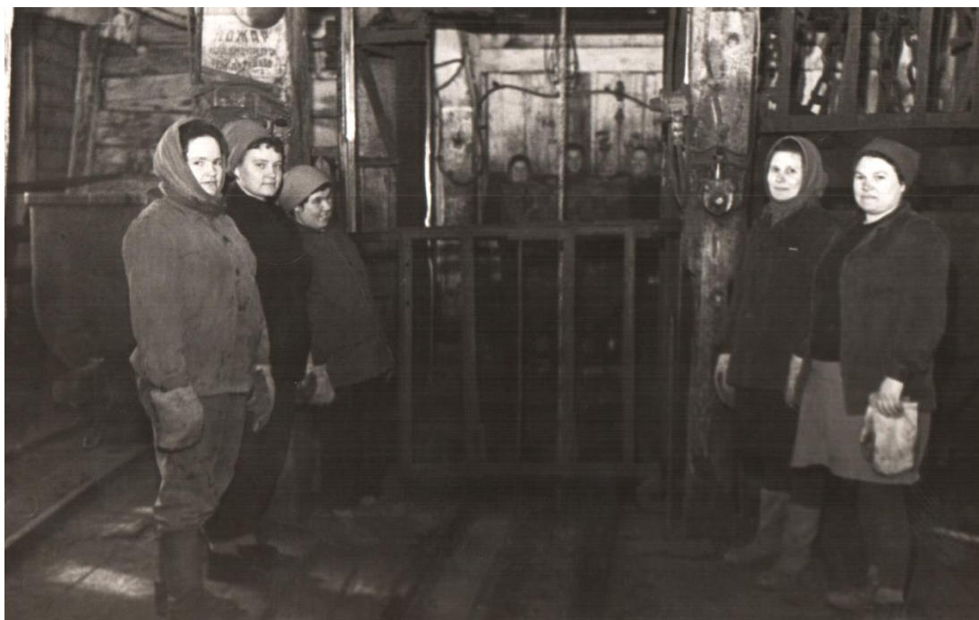
Смена по приёму и отгрузке породы на грузовом подъеме.
