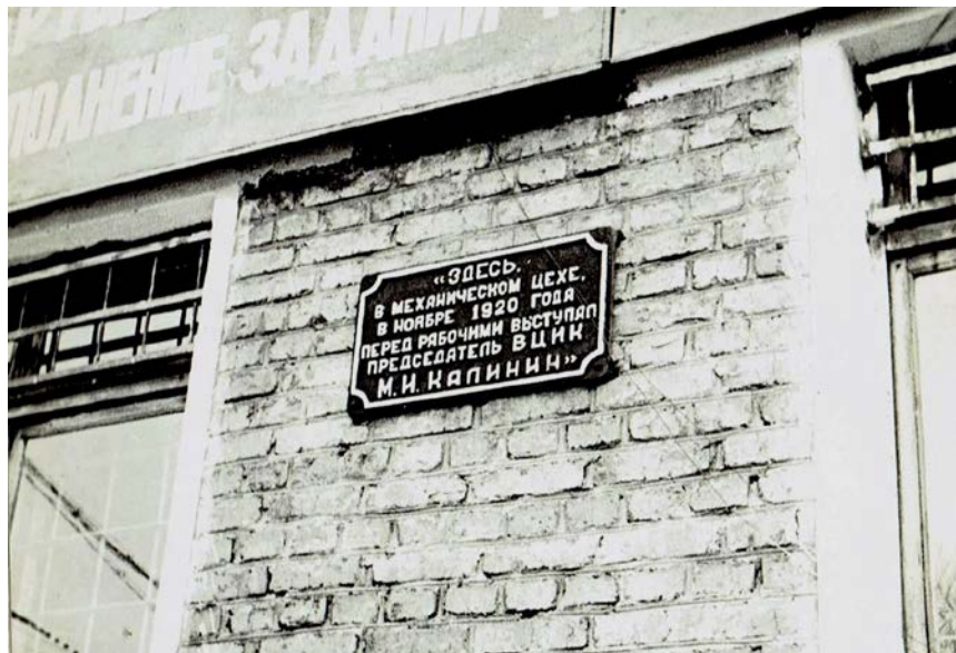
Мемориальная доска на здании машиностроительного завода имени Карла Маркса (бывшего механического завода).
